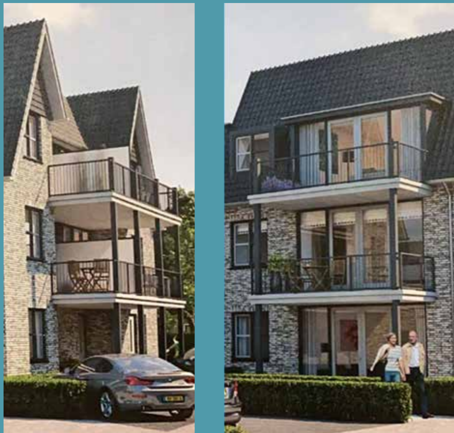
Voorbeeld van gegroepeerde balkons
